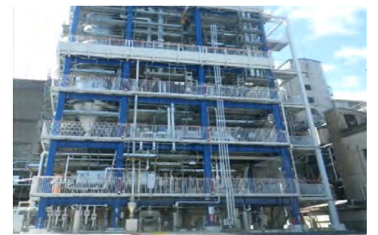
固相重合設備(敦賀事業所)
