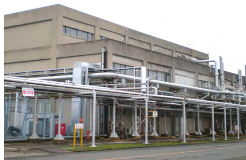
動力棟耐震補強工事
