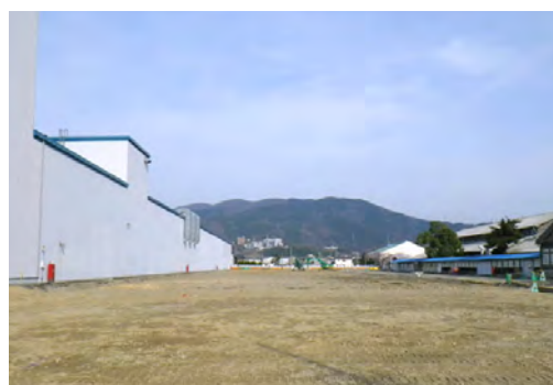
JT-5建設予定(敦賀事業所)
