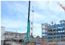
建築中のバイオ棟
