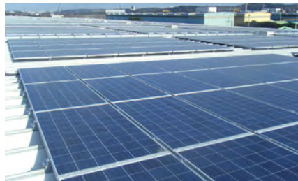
太陽光発電設備工事
