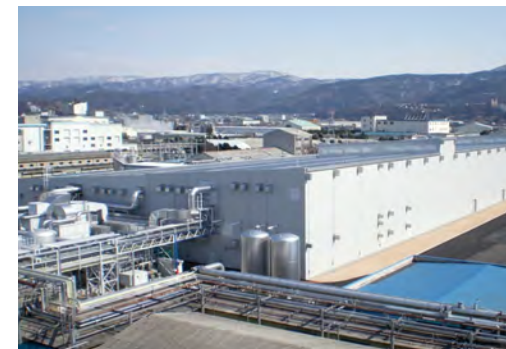
ダイニーマ3、4号機増設工事（敦賀事業所）
